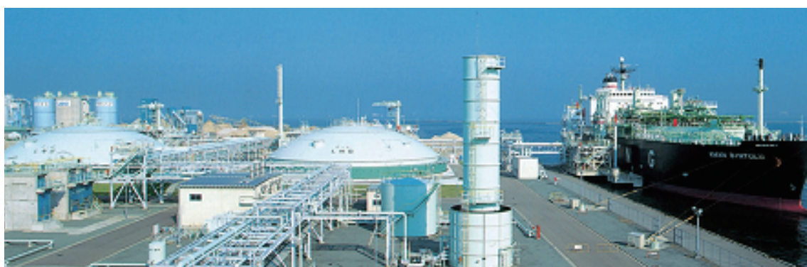
写真 現在の都市ガス製造工場(当社福北工場)
