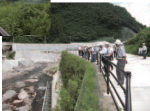
ダム上流取水口付近
