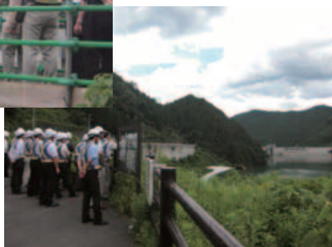
貯水池から堤体を望む
